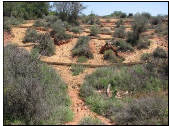
4. Op steiler terreine word heinings in rye Teen die helling af geïnstalleer. Let op die bedekte areas tussen die heinings.
