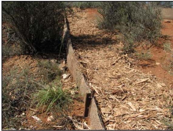
3. Geo-tekstiel moet altyd saam met draadheining gebruik word.
