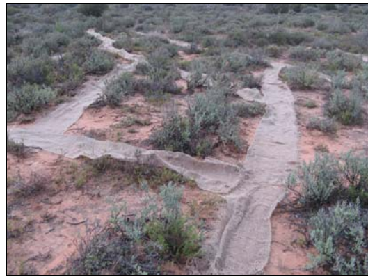
2. Goiinggeo-tekstiel ( Soilsaver ) is gesny en in die voetpaaie geplaas.
