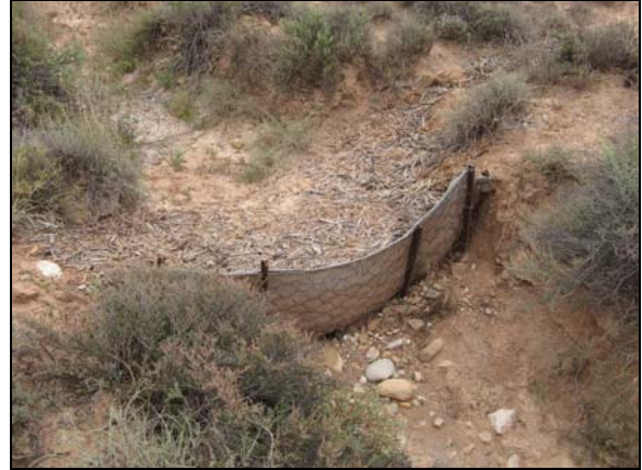
Heinings met 'n deklaag hou watervloei in toom en stabiliseer klein dongas.
